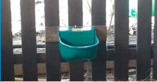
Eau en libre service dans le bâtiment.
